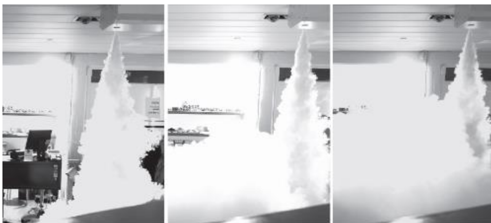
Figura 6: Momento em que o gerador de neblina é acionado.
